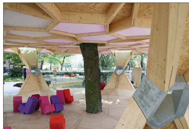
Der Pavillon „Treehugger“ der Handwerkskammer Koblenz zeigt, dass das örtliche Holzhandwerk durchaus in der Lage ist, komplexe Planungsvorgaben exakt umzusetzen.
