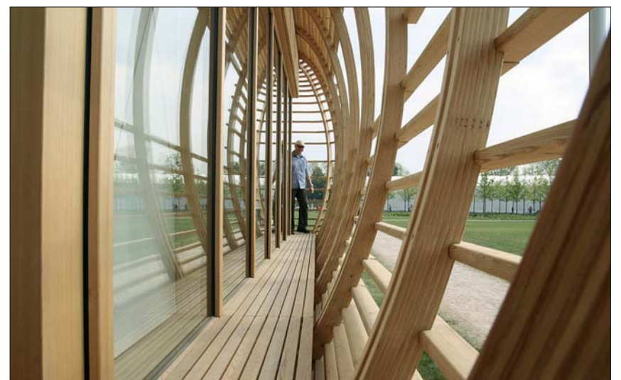
Der „Fincube“ lagert auf nur vier Punktfundamenten; dies erleichtert den temporären Einsatz des Gebäudes sowie die schnelle Montage auf einem Flachdach.
