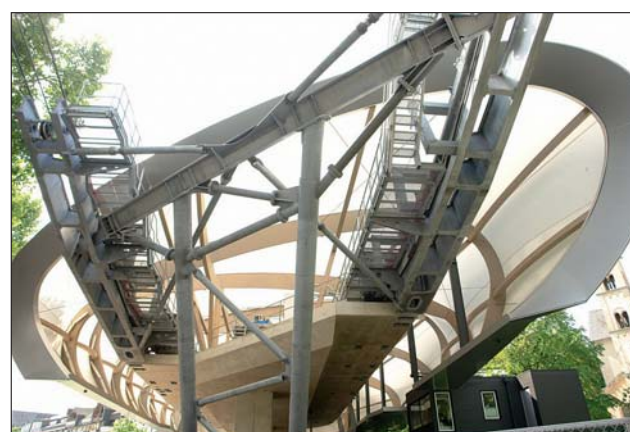
Unter der lichtdurchlässigen Dachhaut der Berg- und Talstation der Seilbahn findet sich eine komplexe Konstruktion aus mehrfach gebogenem Brettchichtholz.
