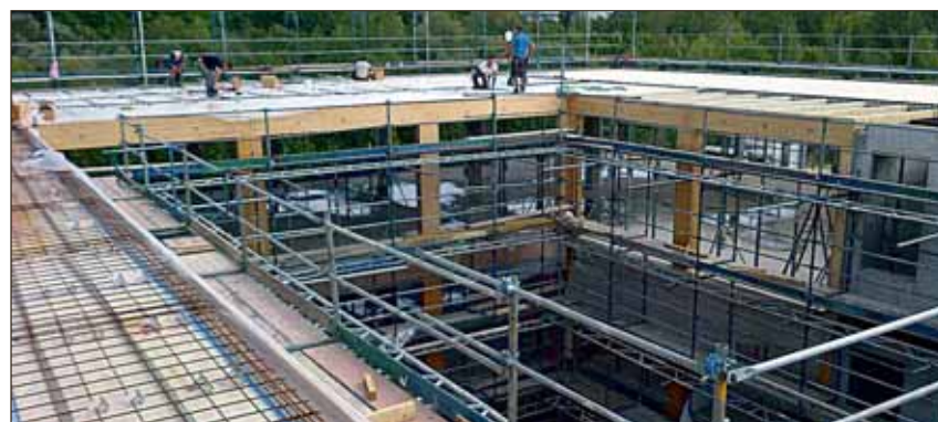
Neubau der Flexible Industriesmesstechnik GmbH (Flexim) in Berlin mit sichtbarer BSH-Konstruktion. Im Bild zu sehen ist ein Teil der Decken vor dem Betonaufrag.
