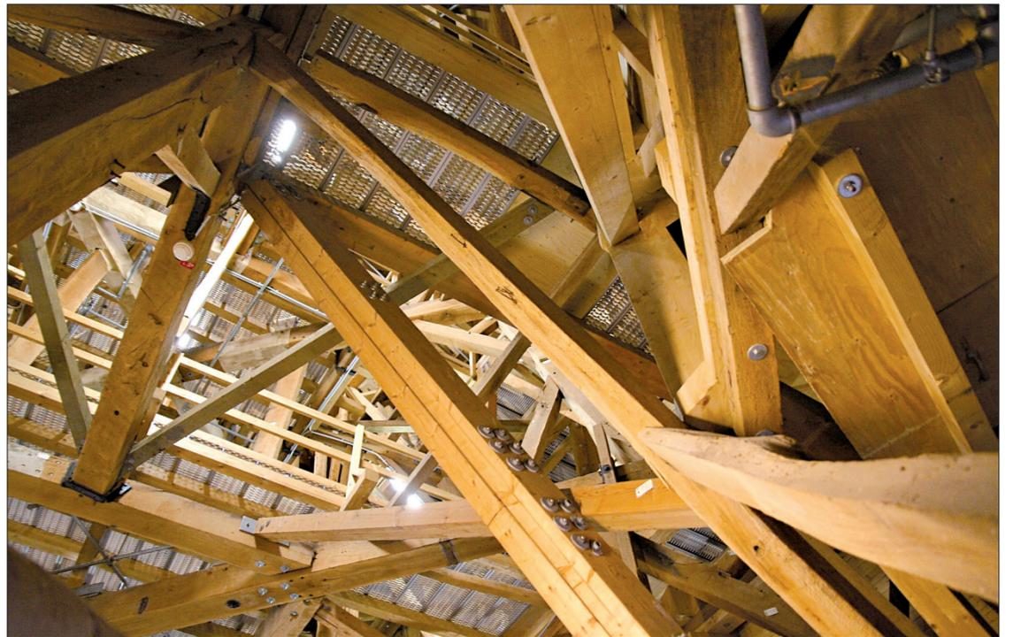
Das Oktogon ist mit über 1200 Jahren der älteste Teil des Aachener Doms. Der barocke Dachstuhl aus dem 17. Jahrhundert wurde seit 2001 mittels einer neu eingefügten Holzkonstruktion grundsaniert
